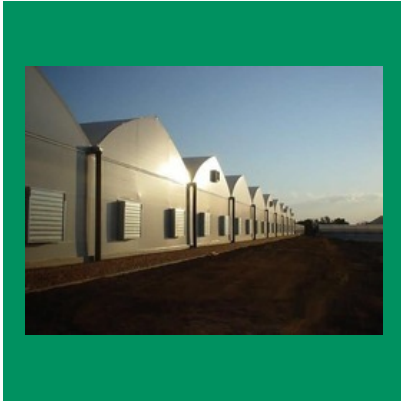
Fan Pad Poly House
